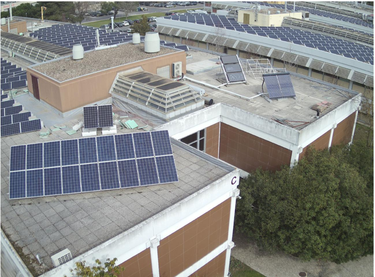
L'installation pilote est alimentée par un système photovoltaïque de 4 kWp, une éolienne de 2,5 kW et un système de batterie de stockage de 30 kWh, le tout intégré dans un système solaire de trigénération qui fournit de l'électricité pour alimenter un micro-réseau. L'énergie pour le confort thermique est fournie par un système de chauffe-eau solaire de 4m<sup>2</sup>, des capteurs solaires à tubes sous vide et un réservoir de stockage
